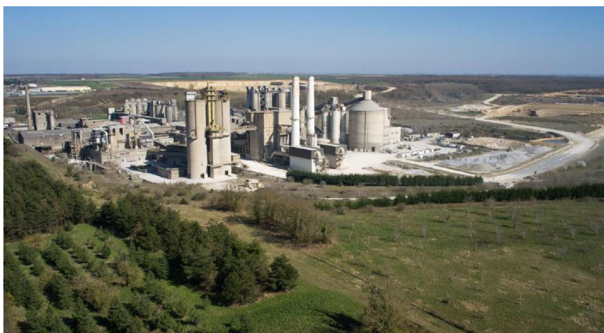
Figure 1 : Photo de la cimenterie actuelle (Source : CIMENTS CALCIA)
